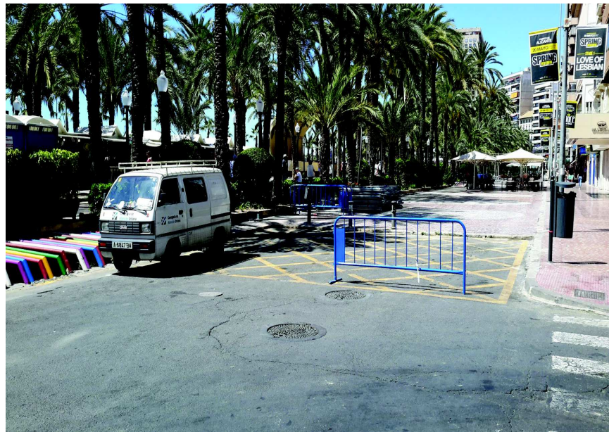
Antigua reserva de estacionamiento eliminada por obras en c/ BILBAO X EXPLANADA
