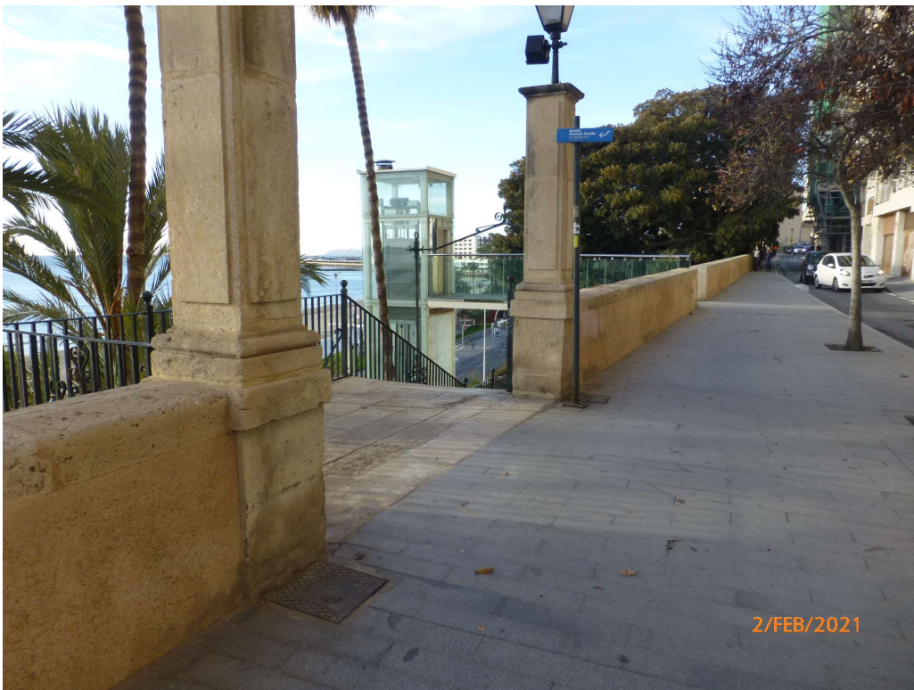
Escalera y ascensor de acceso a la Avenida Jovellanos
