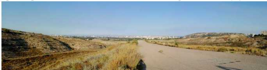
Figura 8. Carretera ejecutada en el interior del ámbito. Fuente: fotografía de elaboración propia
