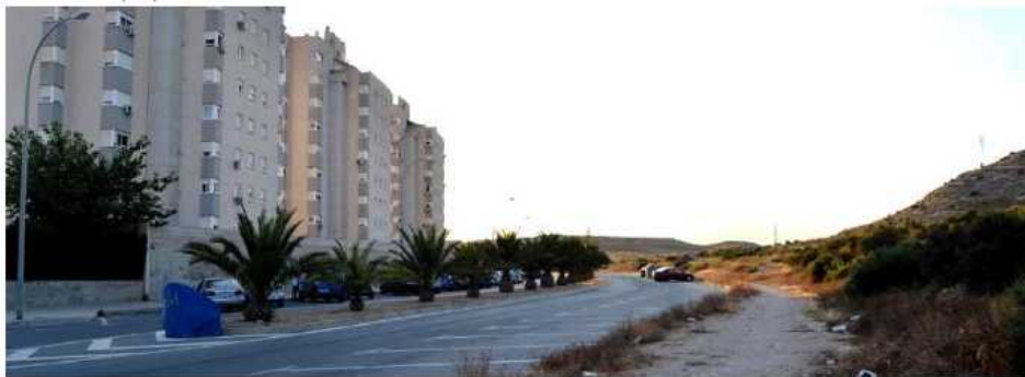
Figura 16. Tramo del bulevar Ronda Norte ejecutado. Fuente: fotografía de elaboración propia
