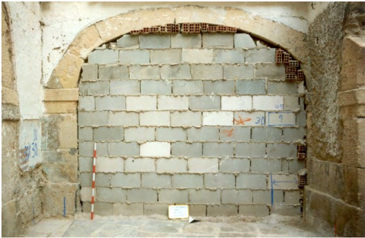
3. ARCO TIPO CARPANEL TALLADO EN PIEDRA.
