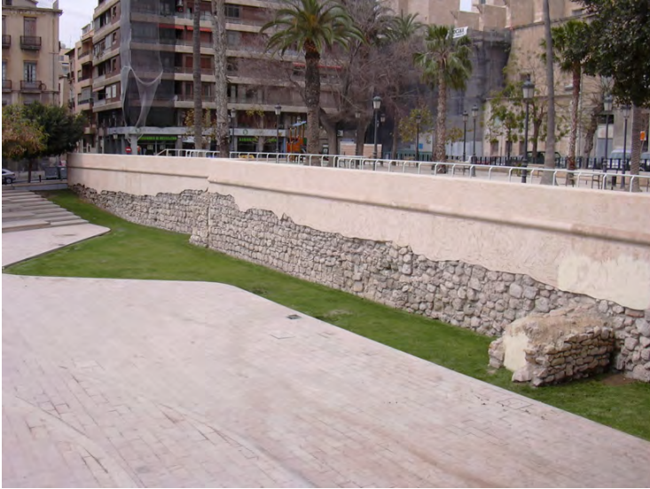
1. VISTA ACTUAL DE LA MURALLA DEL SIGO XVI.
