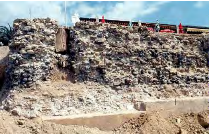
5. SILLERÍA Y TRASDÓS DEL REVELLÍN DE TABARCA
