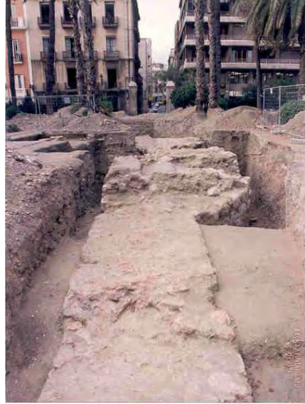
2. MURALLA EN EL MOMENTO DE EXCAVACIÓN.
