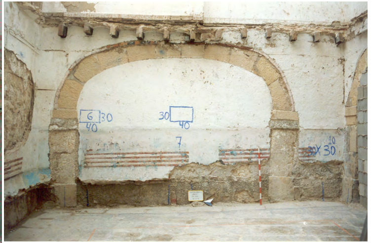
2. ARCO TIPO CARPANEL TALLADO EN PIEDRA.
