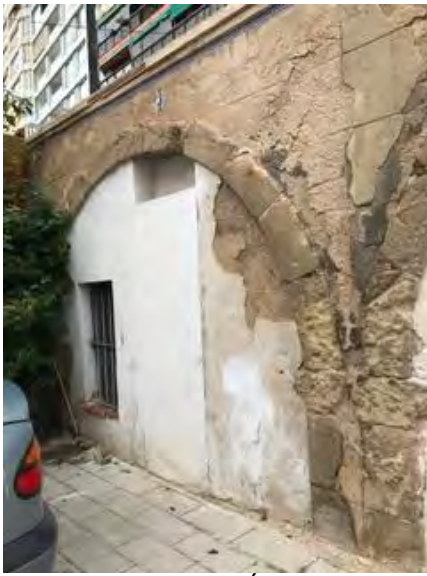
5. VISTA EXTERIOR DE UNA BÓVEDA.
